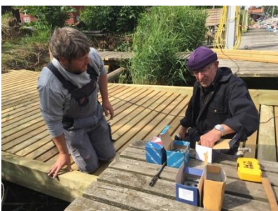
Nicolai Ebbesen til venstre og Marius Terp til højre færdiggør trærampen
