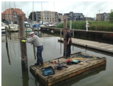
Carsten Mikkelsen til venstre og Nicolai Ebbesen til højre forbereder den yderste forankring af stålrampen
