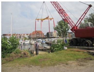
Klubbens kran styret af Gunnar Friis sænker den yderste rampe på plads
