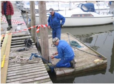
Werner Boisen til venstre på flåden og Valdemar Nielsen til højre arbejder med den inderste forankring, der monteres på pælene
