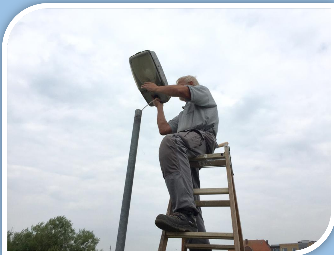
Elektriker Peter Sørensen fra Haderslev Elteknik afmonterer den gamle vejbelystning
